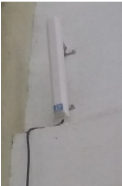
Figura 5. Antena setorial externa do PA-1. Fonte: Elaborado pelo Autor (2016).
