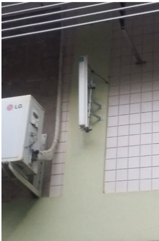
Figura 9: Detalhe com aproximação da antena setorial do PA-3. Fonte: Elaborado pelo Autor (2016).
