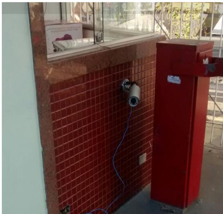
**Figura 30:** Instalação da câmera de captura.
