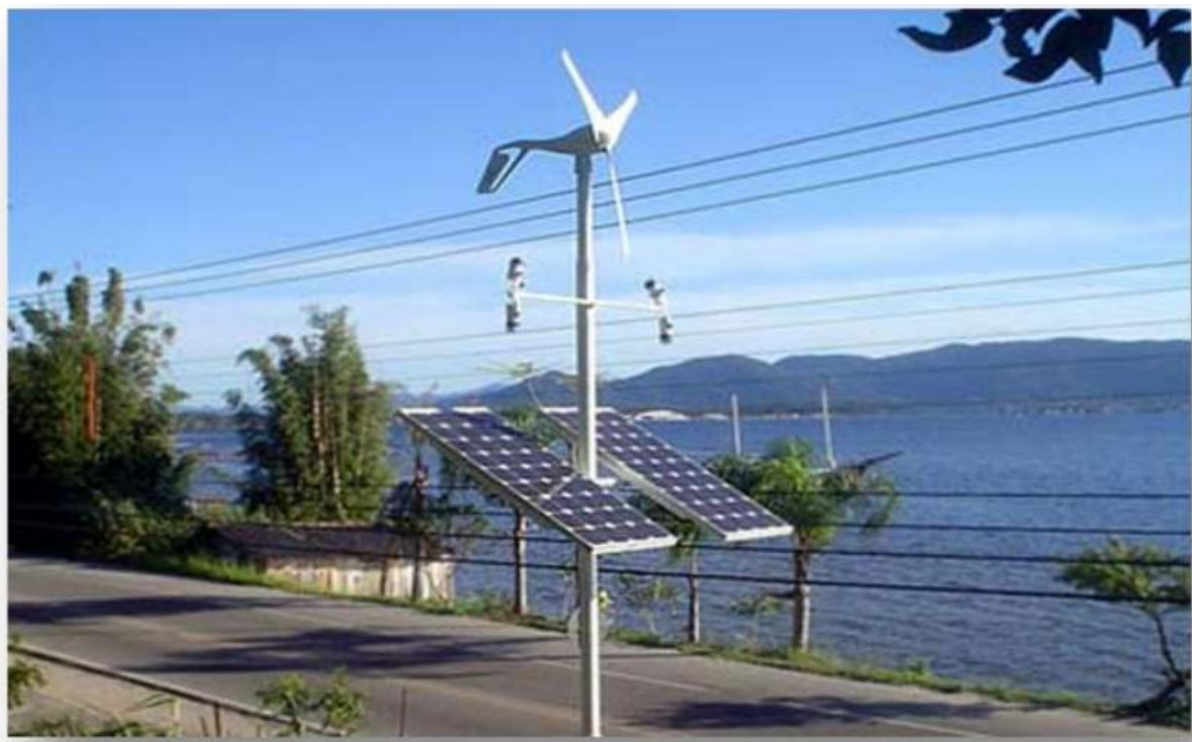
Figura 3: Sistema Híbrido de geração de energia: eólico e solar Fonte: Disponível em: < http://www.google.com.br >, acessado em 2013.
