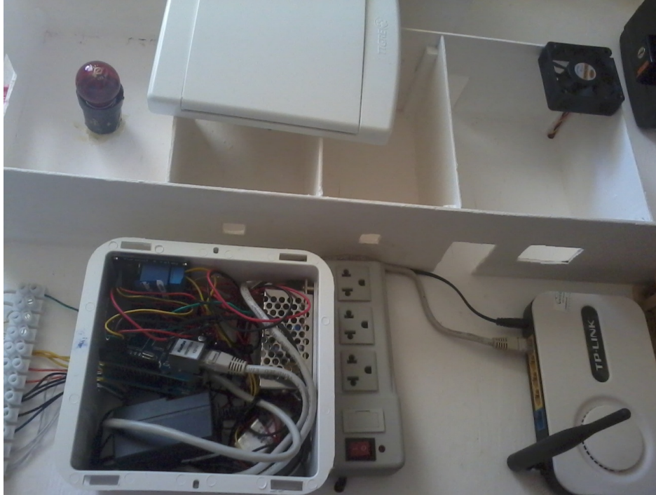
Figura 14: Quadro de Distribuição com o Arduino, suas fontes de alimentação e distribuição dos circuitos para a casa.
